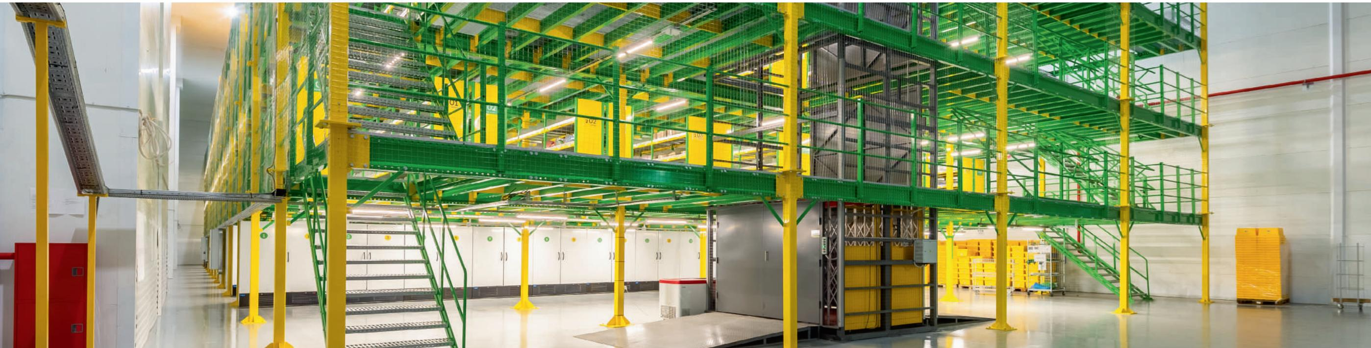
Для обслуживания таких конструкций применяются лестницы с перилами, ограждения и ворота для транспортировки груза на этаж складской подъемной техникой (штабелеры, лифты, подъемники). Опытный завод «Микрон» предлагает различные варианты мезонинных конструкций:
